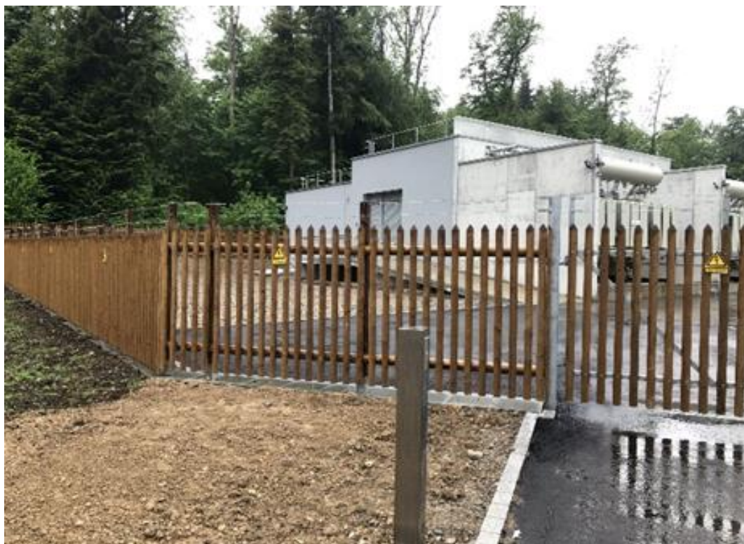
Abbildung 1 Unterwerk Stäfa der EKZ
