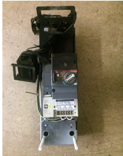
Schaltermodul, kann für den Ersatz des Messgerätes demontiert werden.
