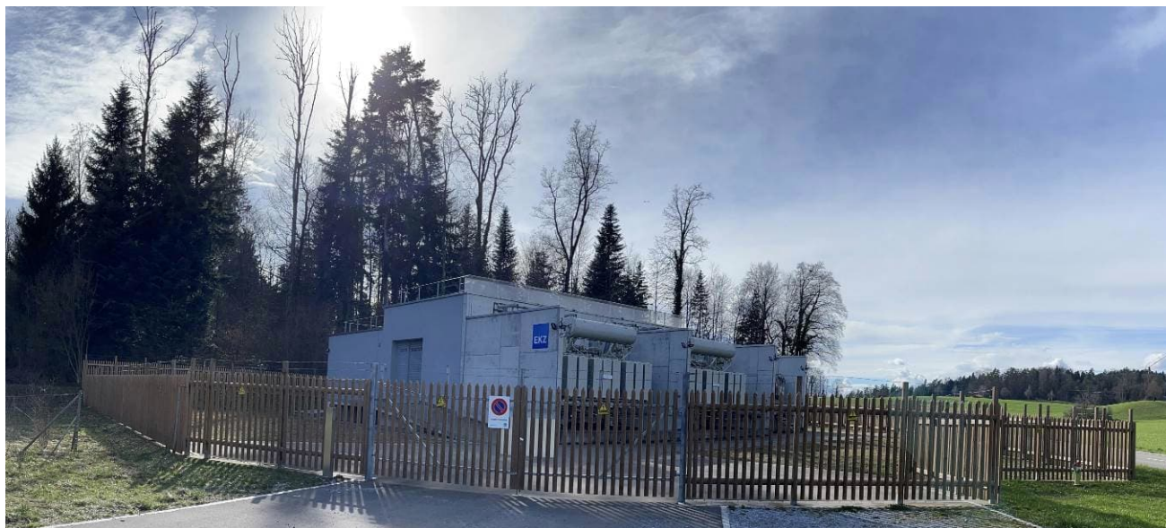
Abbildung 1 Unterwerk Stäfa der EKZ
