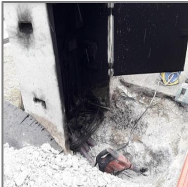
Durch einen Kurzschluss ausgebrannte TV-Verteilkabine
