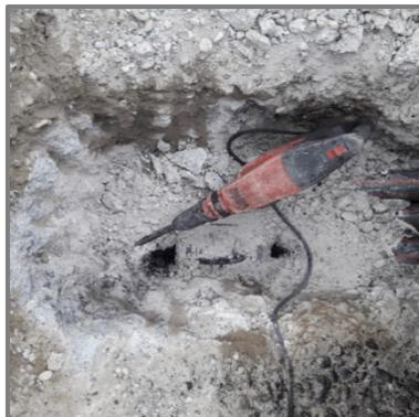
Eingesetzter Spitzhammer, mit dem unabsichtlich ein Kabel beschädigt wurde.
