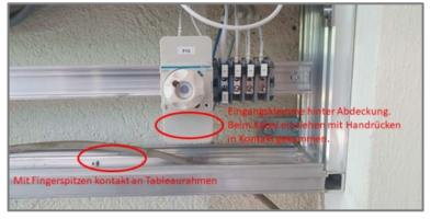
Unfallort: Da der Verunfallte mit den Fingerspitzen den metallenen Rahmen der Hauptverteilung berührte und gleichzeitig in Kontakt mit der unter Spannung stehenden Eingangsklemme kam, erlitt er einen elektrischen Schlag.
