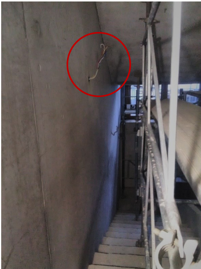
Vano scale (luogo dell'incidente)
