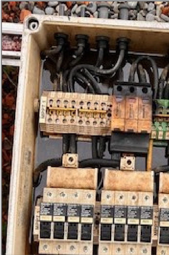
Wasser in PV-Generatoranschlusskasten
