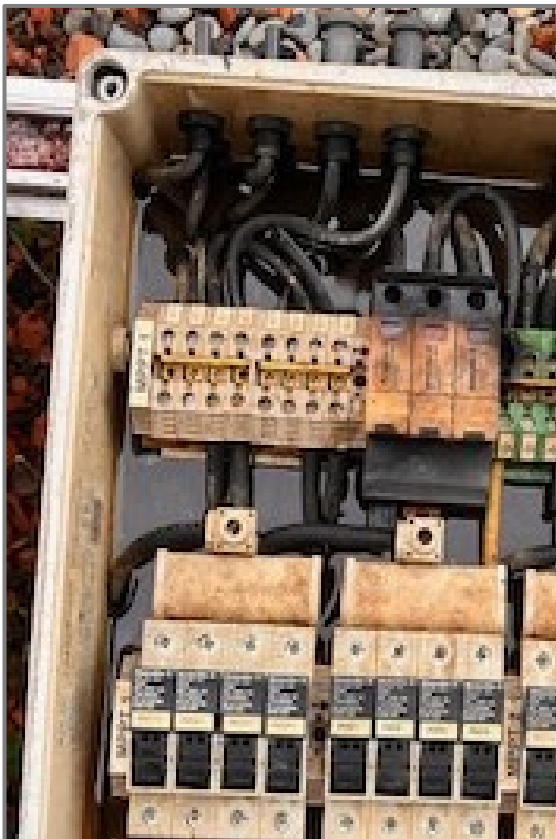
Acqua nella scatola di derivazione del generatore fotovoltaico
