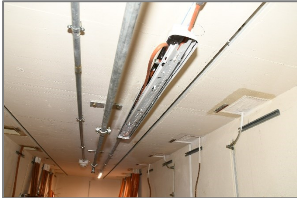
Lampada a LED senza copertura in plastica che ha causato l'incidente.
