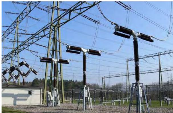
*Figura 2 Interruttori di potenza da 380 kV collegati con gli apparecchi adiacenti mediante conduttori essenzialmente verticali: questa configurazione consente grandi spostamenti sismici senza che i conduttori si tendano.*
