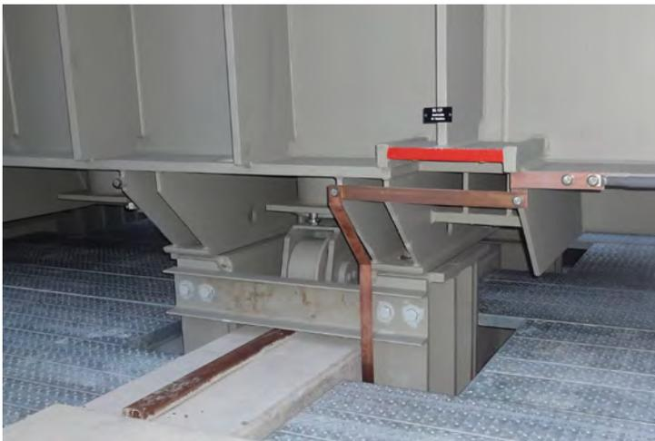
Figura B.4 *Trasformatore 110 kV / 125 MVA – Zona sismica Z2 – Ancoraggi (4 rimovibili) con ruote (con autorizzazione di axpo).*
