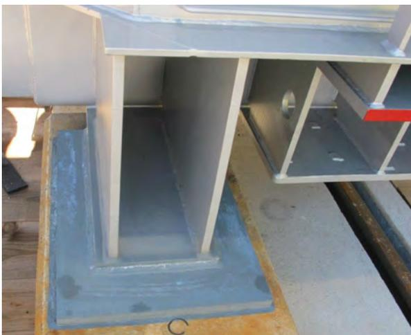
Figura B.2 *Trasformatore 236 kV / 60 MVA – Zona sismica Z3b - Cornice di rinforzo saldata su placche di ancoraggio fissate nel cemento (con autorizzazione di ewz).*
