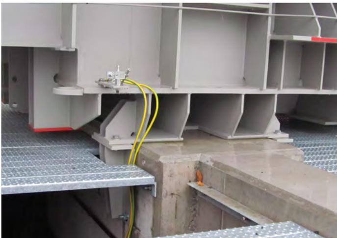
Figura B.1 *Trasformatore 220 kV / 70 MVA – Zona sismica Z3b – Ancoraggi (8 rimovibili) direttamente sul basamento di fondazione (con autorizzazione di Axp).*
