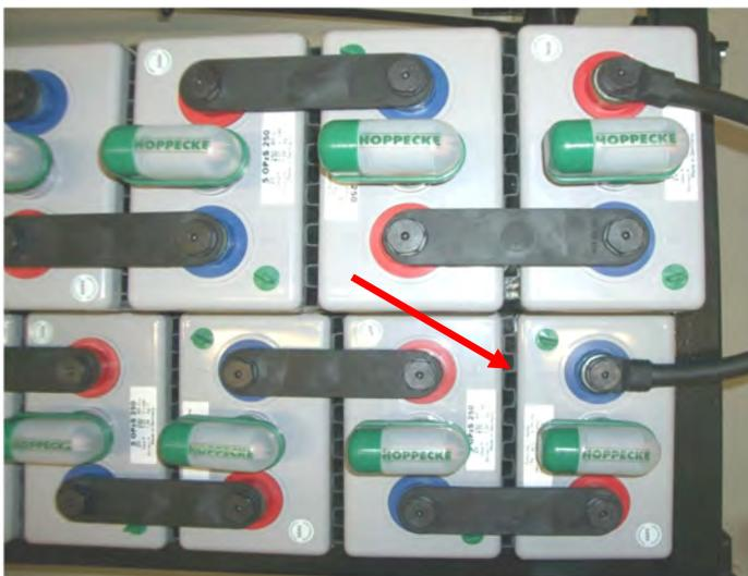
Figura E.3 Sottostazione Münchwilen (Axpö): inserti ondulati in materia plastica posizionati tra batterie adiacenti impediscono che esse battano l'una contro l'altra.
