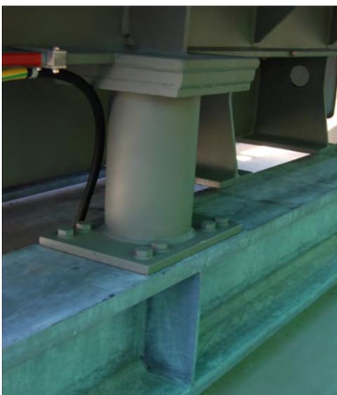
Figura B.5 *Trasformatore 50 kV / 25 MVA – Zona sismica Z1b – Ancoraggio su un basamento di fondazione esistente rinforzato (con autorizzazione di energie thun).*
