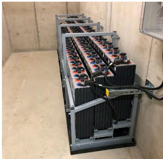
Fig. E.1/E.2 Assicurazione contro il ribaltamento e le cadute di batterie di emergenza: a sinistra, sottostazione Münchwilen (Axpö): Piedini dei supporti controventati diagonalmente e fissati con viti al pavimento / a destra, sottostazione Bassecourt (Swissgrid): assicurazione del supporto contro il ribaltamento mediante fissazione alla parete laterale / le due barre orizzontali impediscono alle batterie di ribaltarsi.
