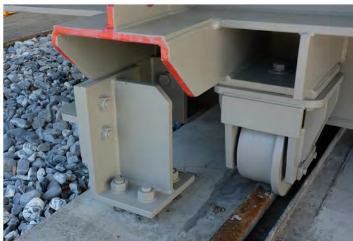
Figura B.3 *Trasformatore 110 kV / 60 MVA – Zona sismica Z2 – Ancoraggi (4 rimovibili) con ruote (con autorizzazione di axpo).*
