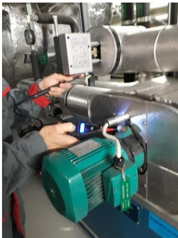
Verifica del conduttore di protezione di un impianto RVCS
