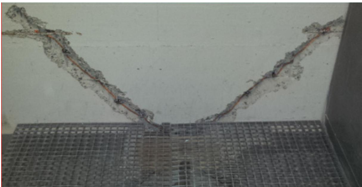
**Figur 11 Erdungskreuz: Anschlussstelle ZS für den Schutzpotenzialausgleich, symmetrische Anordnung**
