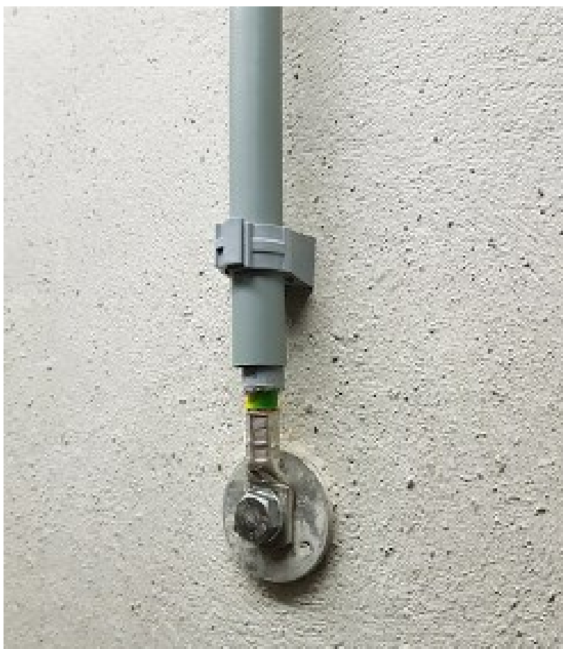
Figur 14 Nachträglicher Einbau der Anschlussstelle ZS für den Schutzpotenzialausgleich
