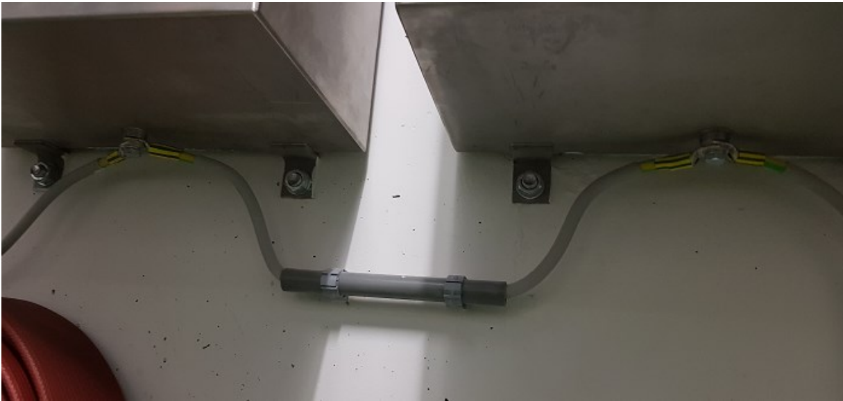
Figur 15 Nachträglicher Einbau der Anschlussstelle ZS für den Schutzpotenzialausgleich
