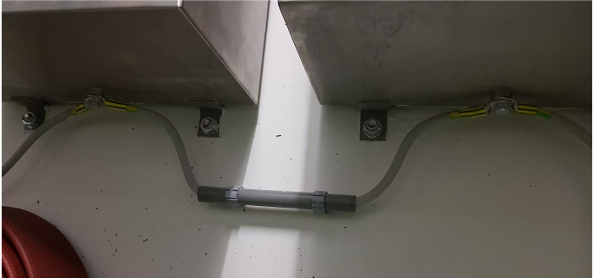
**Figure 16 Extension selon les ITMO dans des ouvrages de protection existants avec «mise au neutre selon le schéma III»**
