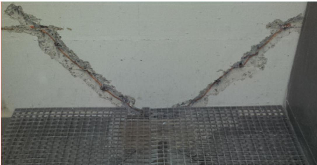
**Figure 11 Croix de terre: point de raccordement ZS pour la liaison équipotentielle de protection, disposition symétrique**
