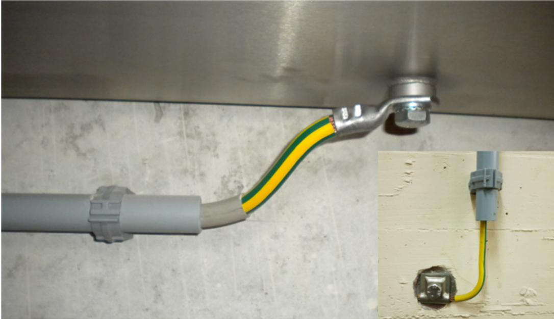
**Figura 14 Installazione successiva del punto di connessione ZS per il collegamento equipotenziale di protezione**
