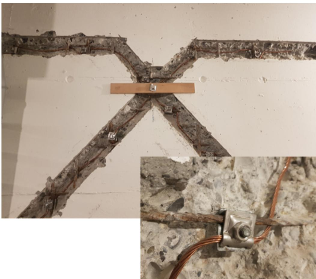
**Figura 11** Dispensore di fondazione a croce: punto di connessione ZS per il collegamento equipotenziale di protezione, disposizione simmetrica
