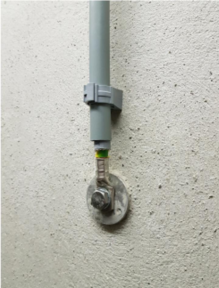
**Figura 15** Installazione successiva del punto di connessione ZS per il collegamento equipotenziale di protezione
