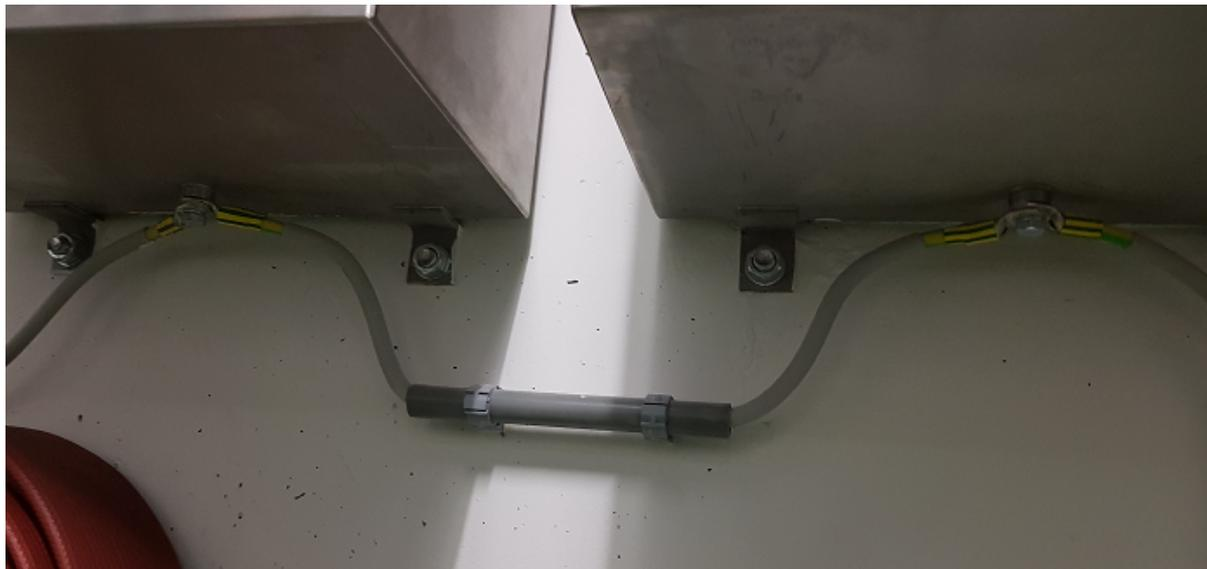
**Figura 16** Ampliamento secondo le TWE per costruzioni protette esistenti con "messa al neutro Schema III"
