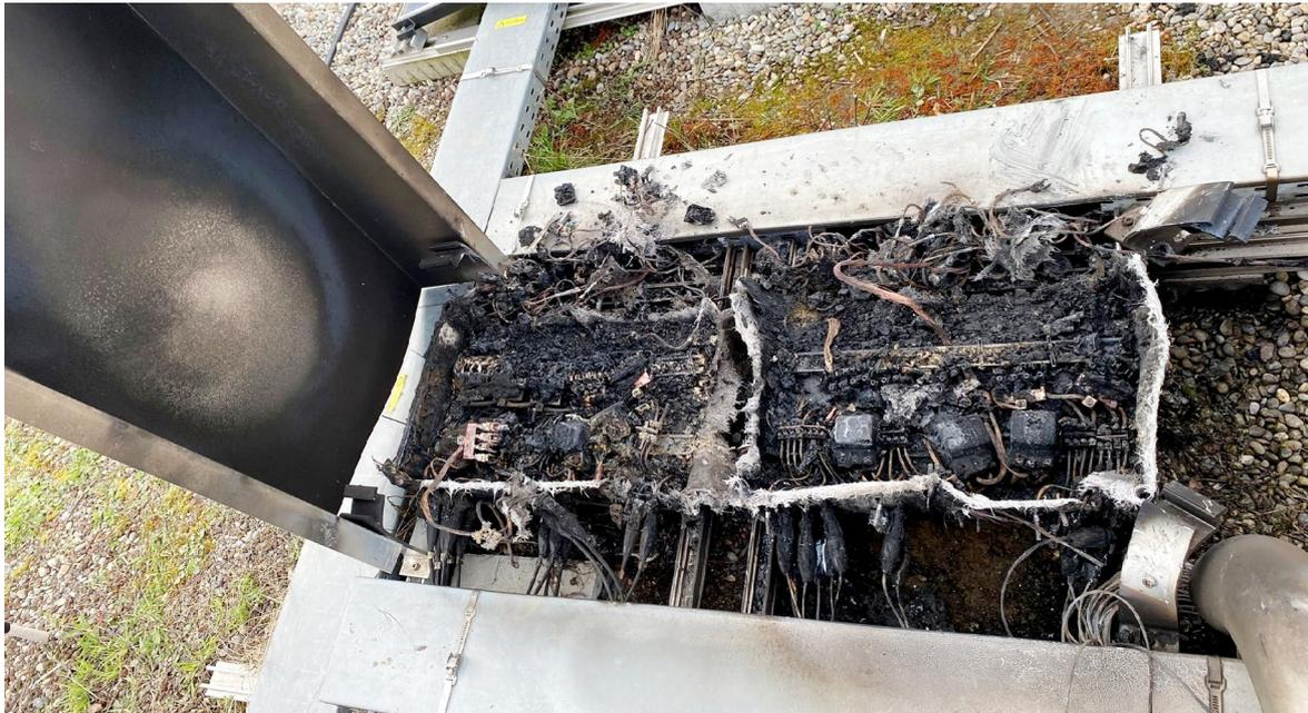
**Illustration 8:** Court-circuit sur le boîtier de raccordement du générateur d'une installation photovoltaïque
