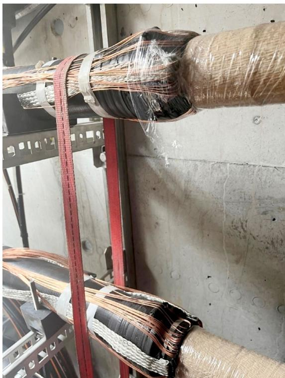
**Illustration 3** Point de raccordement préparé pour le manchon de câble de la ligne entre les sous-stations de Schwanden et de Löntsch
