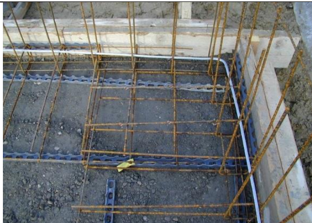
Image 1 : Un expert doit contrôler la bonne exécution des installations de mise à la terre avant le remblayage et la terre de fondation avant le bétonnage ; alternativement, d'entente avec l'autorité de prévention des incendies ou l'organe de contrôle, il convient de documenter la bonne exécution par des photographies. Voir : SNG 483755 + SNR 464113
