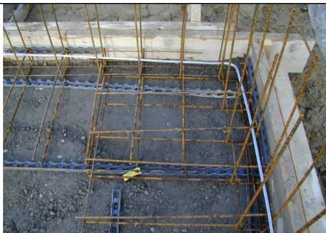
Bild 1: Erdungsanlagen sind vor der Eindeckung und der Fundamenterder **vor dem Einbetonieren** durch eine Fachperson auf ihre richtige Ausführung zu kontrollieren oder nach Absprache mit der Brandschutzbehörde oder dem Kontrollorgan mit Bildmaterial zu dokumentieren.
