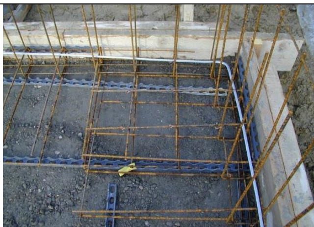
Figura 1: la corretta esecuzione degli impianti di terra prima della copertura e dell'elettrodo di terra nello scavo di fondazione prima della gettata di cemento deve essere controllata da una persona esperta oppure deve essere documentata mediante materiale fotografico d'intesa con l'autorità competente in materia di protezione contro gli incendi o l'organo di controllo.
