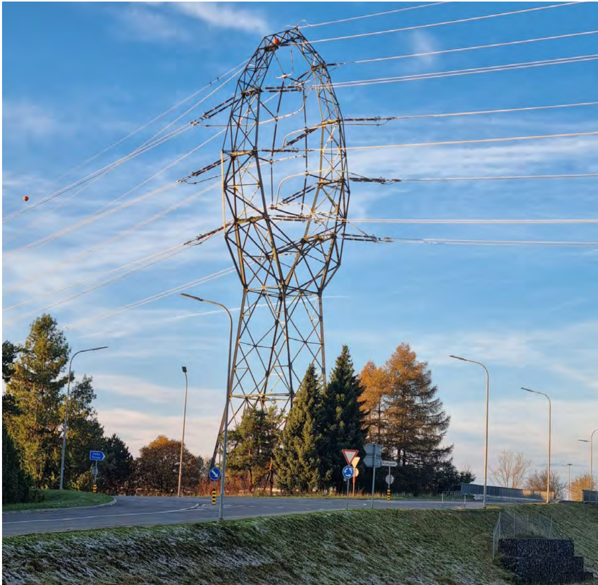
Illustration 3 Pylône de ligne aérienne 132/380 kV inspecté près de la sous-station de Romanel
