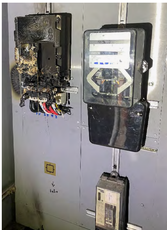
Illustration 4 Accident électrique sur un compteur d'énergie dans un ensemble d'appareillage existant
