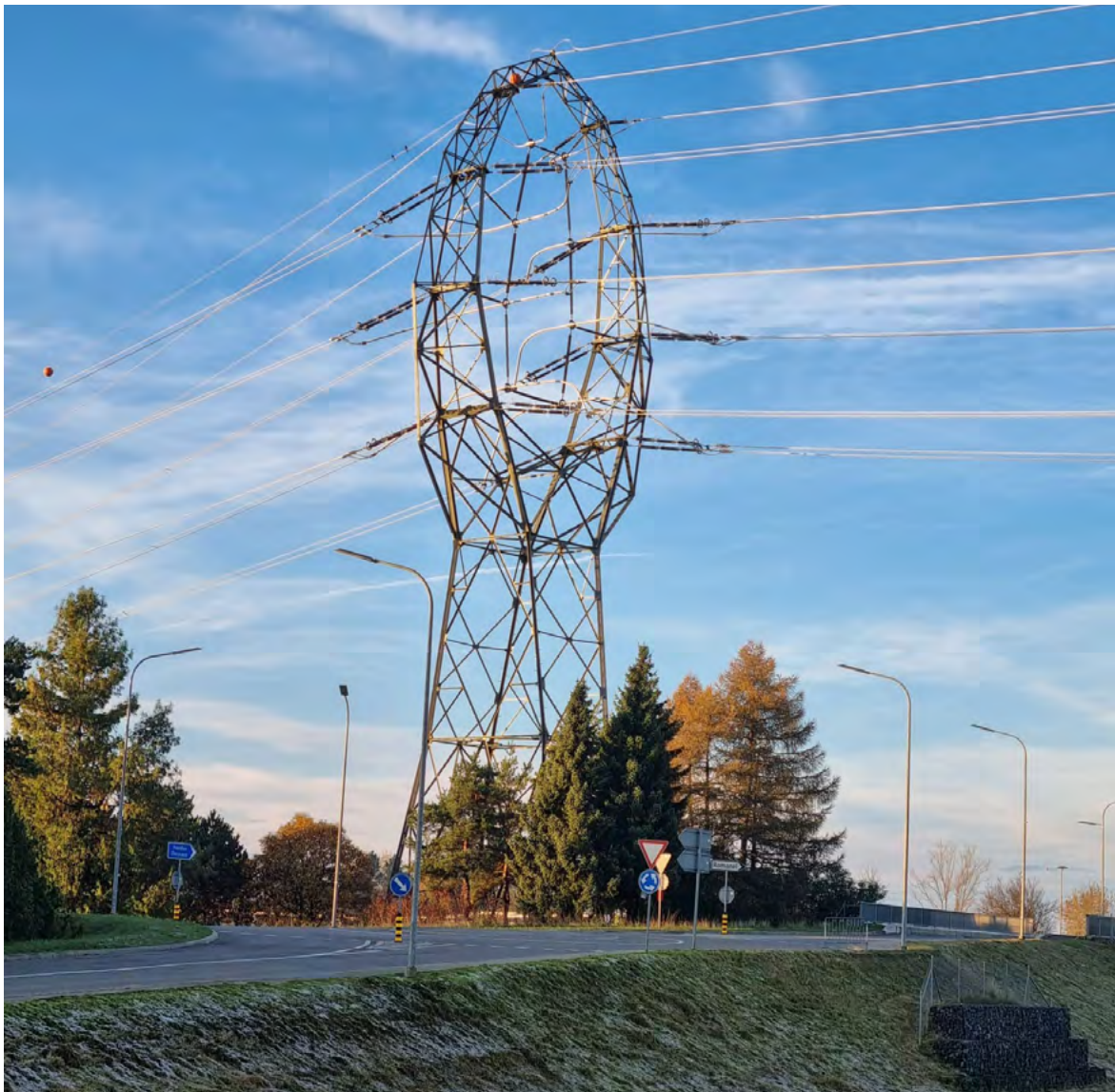
Abbildung 3 Inspizierter Freileitungsmasten 132/380 kV beim Unterwerk Romanel
