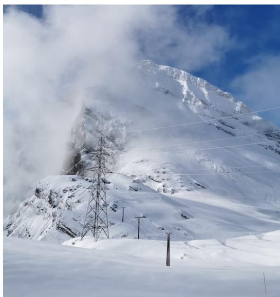
**Abbildung 1** Die «Gemmileitung» Chippis-Bickigen im Winter: Wie bereits im Vorjahr wurden auch 2023 Vorbereitungen getroffen, um bei einer Strommangellage die Leitung temporär mit 380kV zu betreiben. Bild: Pirmin Romer, Winterthur
