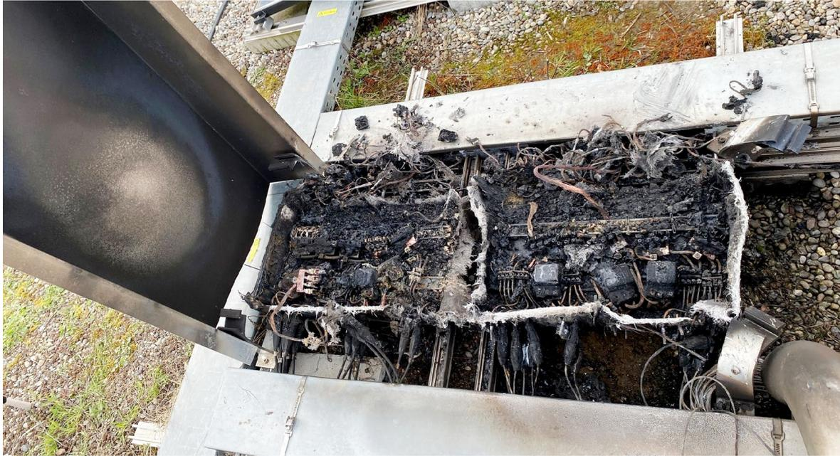
**Abbildung 8:** Kurzschluss am Generatoranschlusskasten (GAK) einer Photovoltaikanlage
