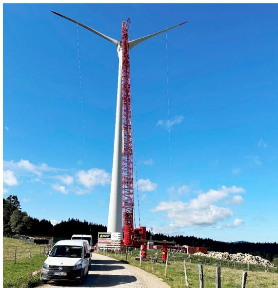
**Abbildung 4** Windpark Sainte-Croix: Montage des Rotorblattes am Windrad
