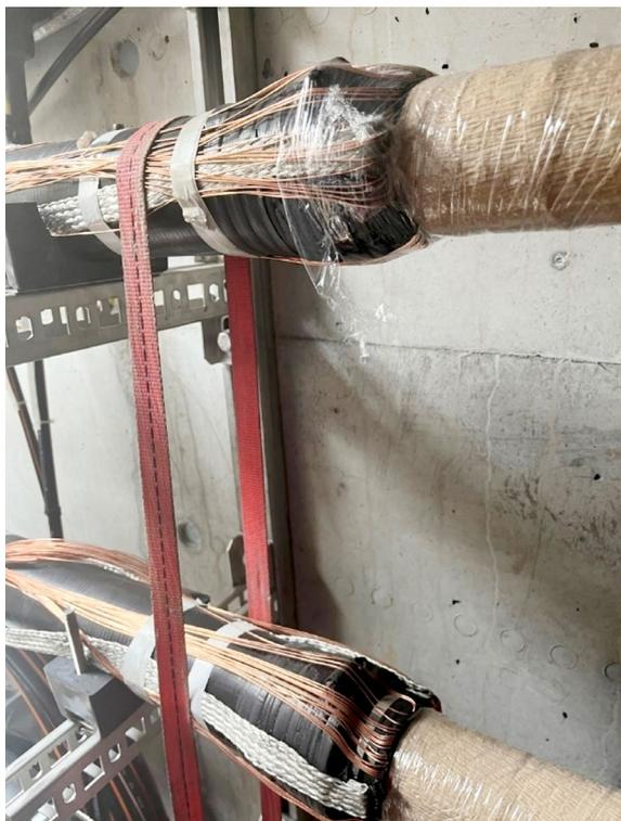
**Abbildung 3** Vorbereitete Verbindungsstelle für die Kabelmuffe der Leitung zwischen den Unterwerken Schwanden und Löntsch
