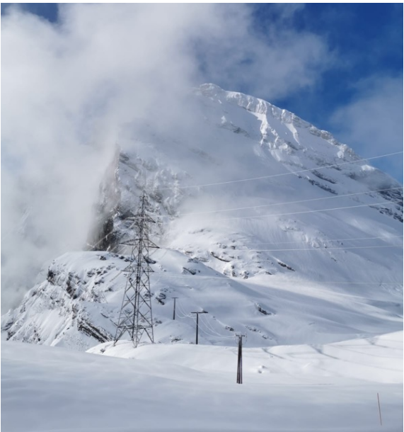
Figura 1 La «linea Gemmi» Chippis-Bickigen in inverno: come già nell'anno precedente, anche nel 2023 sono stati predisposti dei preparativi per poter azionare temporaneamente la linea a 380 kV in caso di penuria di elettricità. Immagine: Pirmin Romer, Winterthur
