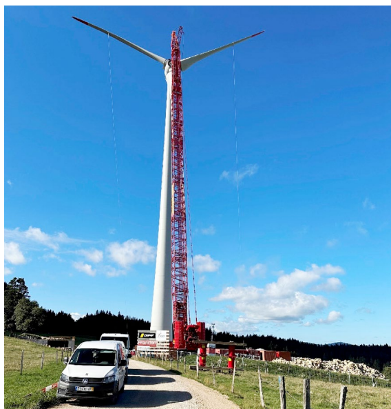
Figura 4 Parco eolico di Sainte-Croix: montaggio della pala del rotore sulla turbina eolica
