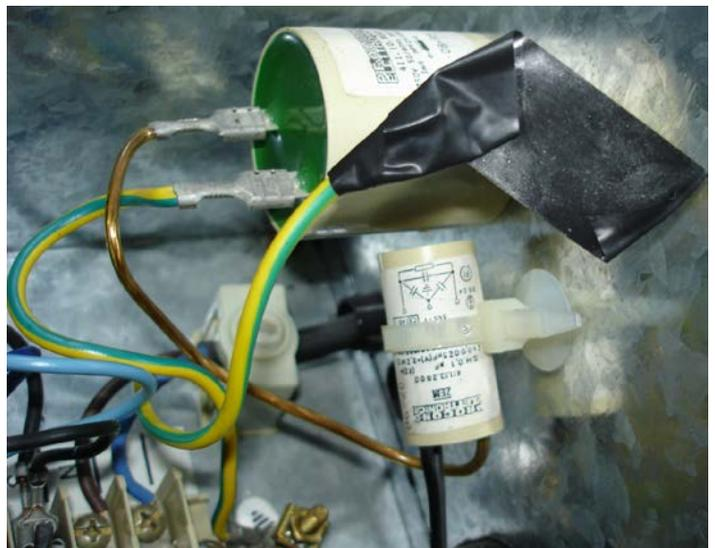
Abgehängter Schutzleiter, den der Servicemonteur löste und isolierte.
