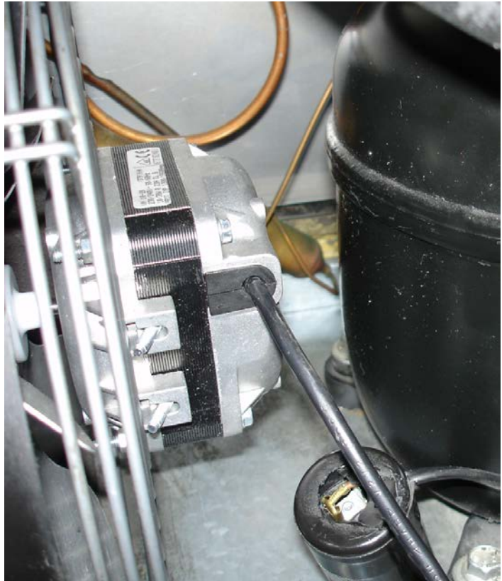
Ventilateur qui a été remplacé pendant les réparations.
