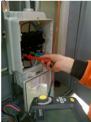
**INTERDIT** : Saisir la protection contre les contacts sous tension avec le pouce et l'index
