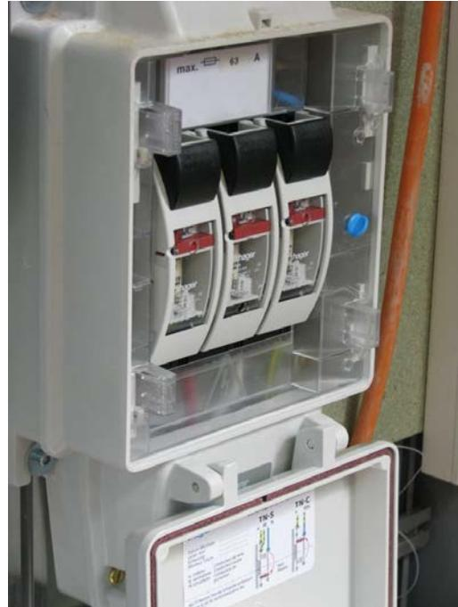
Boîtier de raccordement d'immeuble avec protection contre le contact et vérifiable sans coupure. (photo 4)
