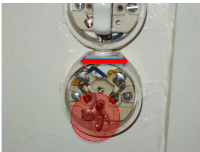
Figure 1 : Dispositif joncteur T 14 Conducteur de phase (conducteur polaire) – conducteur de neutre inversé dans une mise au neutre selon le schéma III, le PE est à présent sous tension.
