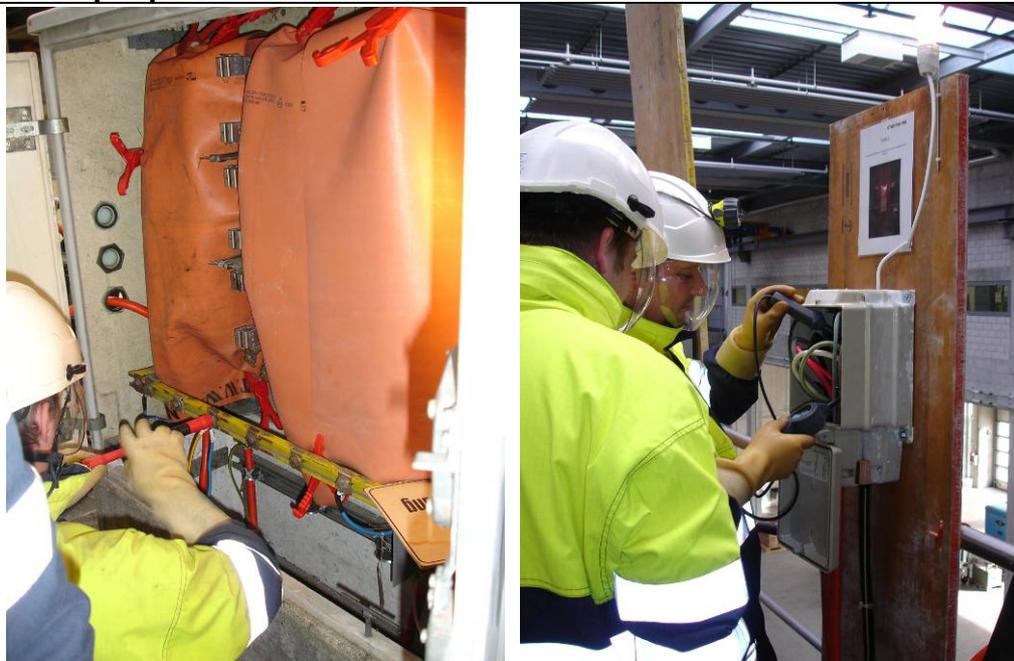
**A gauche : élément de coupe-circuit, changement avec recouvrements isolants**
