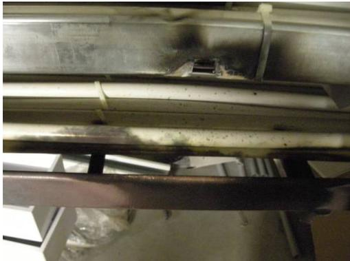
L'accidenté avait sorti le vieux matériel de la pièce et monté des étagères. Il voulait fixer un panneau en pavatex sur un caniveau de câbles ouvert. Pour cela, il a utilisé une perceuse à accu ainsi que des vis autocoupantes en acier.
