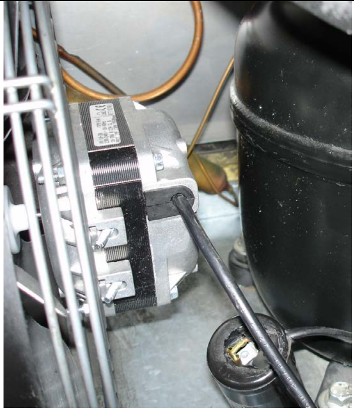
Ventilatore sostituito durante la riparazione.
