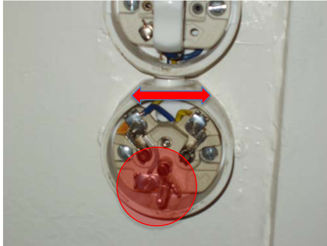
Figura 1: dispositivo d'innesto T14 conduttore polare - conduttore neutro scambiati nella messa al neutro secondo lo schema III, tramite il ponte N-PE il PE è adesso sotto tensione
