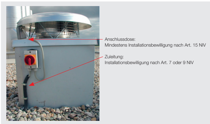
Foto 2 Fest angeschlossenes Erzeugnis (z.B. Dachventilator).
