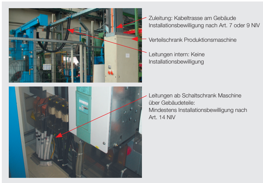
Foto 3 Errichten des Erzeugnisses (Produktionsmaschine) setzt das Verlegen von elektrischen Leitungen voraus.
