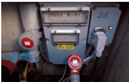
Bild 1 Unterirdischer Verteilkasten.
