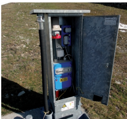
Bild 2 Oberirdischer Verteilkasten.
