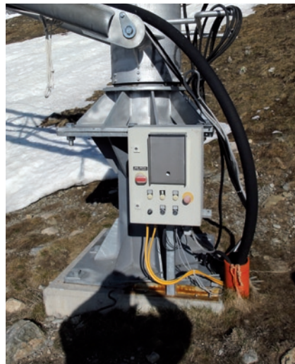
Bild 3 Ungeschützte Kabel zu Verteilkasten. Nicht normenkonform!
