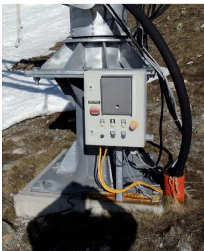
Illustration 3 Câble non protégé vers l'armoire de distribution. **Non conforme à la norme !**
