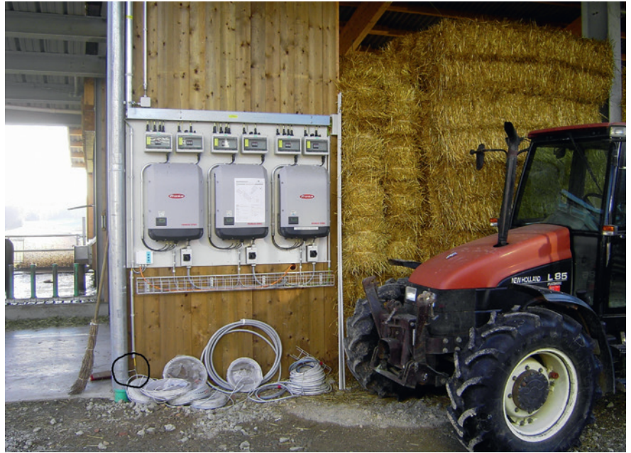
Figure 2 Onduleurs dans une zone à risque d'incendie, distance de séparation à la protection parafoudre non respectée.
