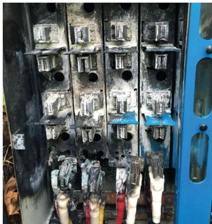
**Figure 6** Ensemble d'appareillage endommagé par un court-circuit en raison d'un défaut de déclenchement.
