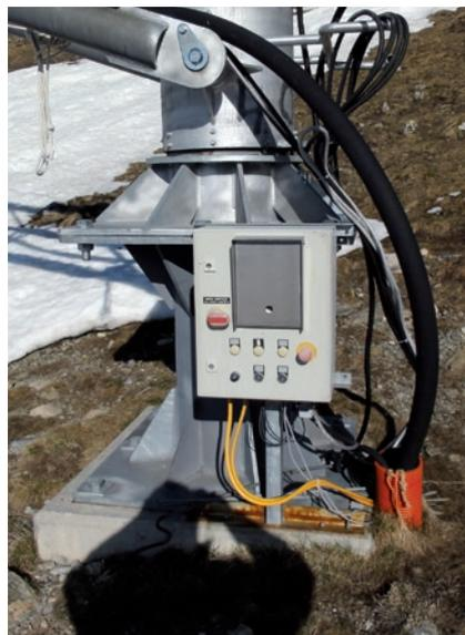
Figura 3 Cavo di alimentazione dell'armadio di distribuzione non protetto. **Non conforme alle norme!**
