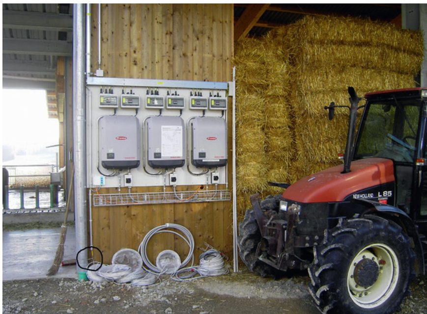
Figura 2 Inverter in zona a rischio d'incendio, distanza di separazione dall'impianto di protezione contro i fulmini non rispettata
