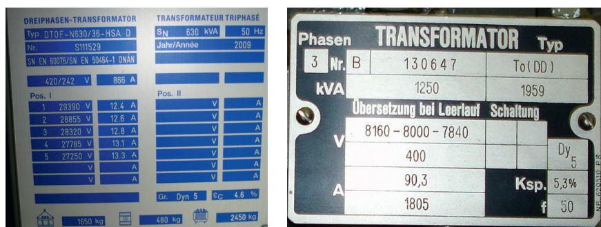
Figura 2 La targhetta di un trasformatore riporta la tensione di cortocircuito in % della tensione nominale, ad es. tensione di cortocircuito del 5,3 %.
