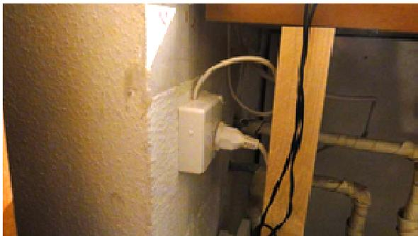
Prise sans raccordement au conducteur de protection installée par des non-professionnels.
