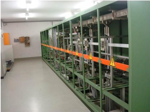
Distribution principale à basse tension ouverte sous tension.
