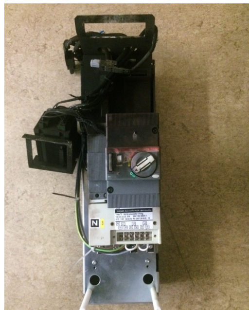
Module de disjoncteurs, peut être démonté pour remplacer l'appareil de mesure.
