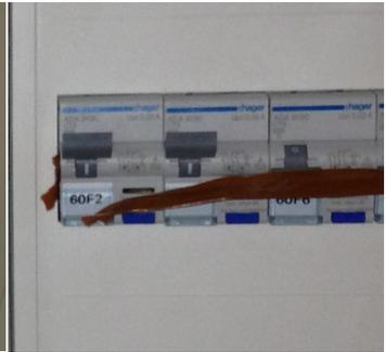
Bloccare gli interruttori automatici in posizione "disinserito" con del nastro adesivo non basta per garantire la protezione contro il reinserimento.
