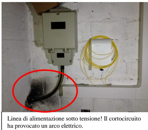
Linea di alimentazione sotto tensione! Il cortocircuito ha provocato un arco elettrico.
