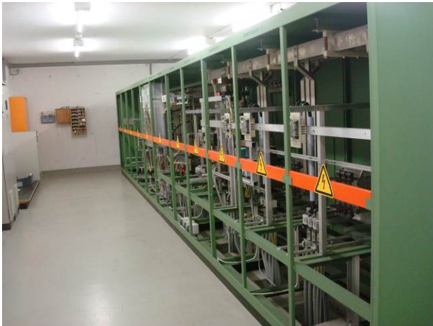
Offene Niederspannungs-Hauptverteilung unter Spannung.
