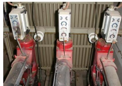
**Bild 3** Brandspuren eines 3-poligen Kurzschlusses in einer Mittelspannungszelle, ausgelöst durch Eindringen in die Annäherungszone durch den Verunfallten. Er erlitt dabei schwere Verbrennungen, da er die persönliche Schutzausrüstung nicht verwendete.
