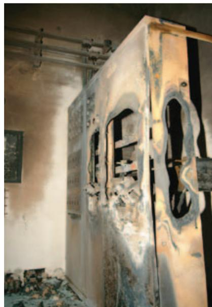
**Illustration 4** Ensembles d'appareillage endommagés par un court-circuit.
