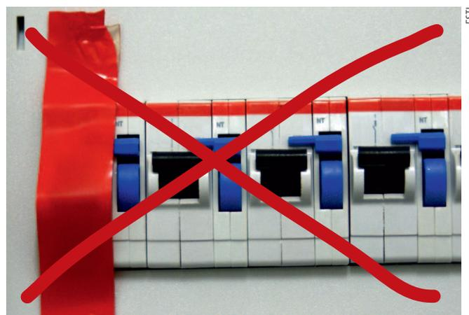
Figure 2 Recouvrir d'un ruban adhésif n'est pas une protection suffisante contre le réenclenchement.
