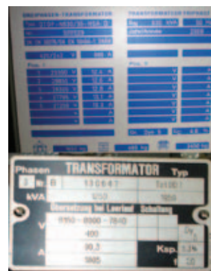
Figura 1 Sulla targhetta del tipo di un trasformatore si deve indicare la tensione di cortocircuito in % della tensione nominale, ad es. tensione di cortocircuito del 5,3 %.
