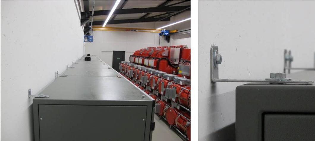
Bild E.4/E.5 Sicherung von Steuerschränken mit Stahlwinkeln an Wand (Axpö)
