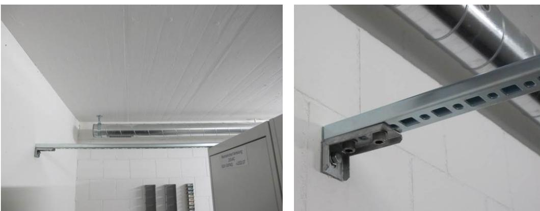
Bild E.7/E.8 Sicherung von Steuerschränken in Raummitte bis an die Wand (Axpö)
