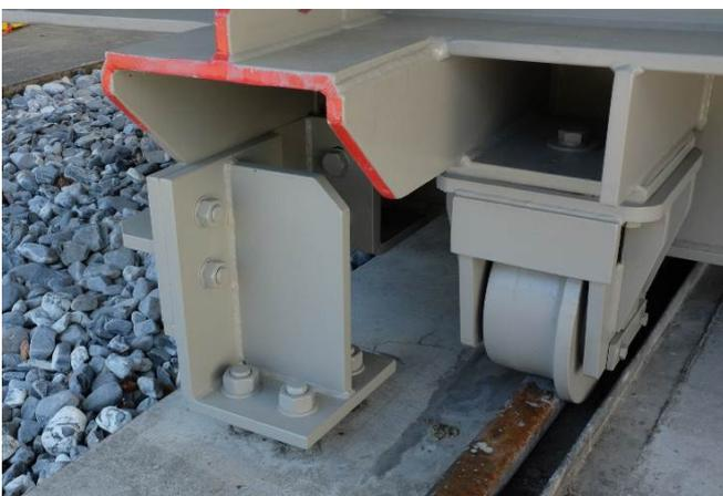
**Bild B.3** Trafo 110 kV / 60 MVA – Erdbebenzone Z2 – Verankerungen (4 lösbare) mit Fahrrollen (mit Erlaubnis von Axpo).
