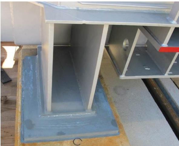
**Bild B.2** Trafo 236 kV / 60 MVA – Erdbebenzone Z3b – Verschweissung mit Verstärkungsrahmen auf einbetonierten Verankerungsplatten (mit Erlaubnis von ewz).
