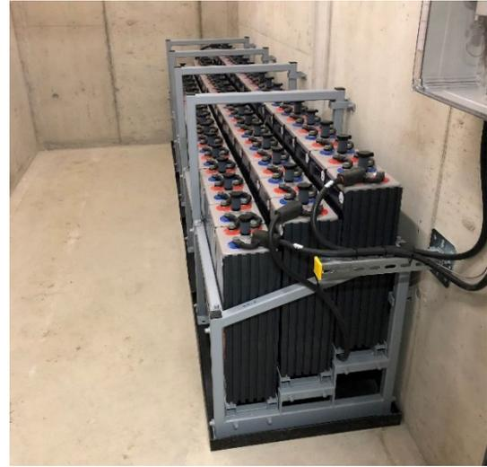
Bild E.1/E.2 Kipp- und Absturzsicherung von Notstrombatterien: links, UW Münchwilen (Axpö): Füsse der Gestelle diagonal verstrebt und am Boden festgeschraubt / rechts, UW Bassecourt (Swissgrid): Kippsicherung vom Gestell gegen Seitenwand / beide, horizontale Profile verhindern ein Abkippen der Batterien
