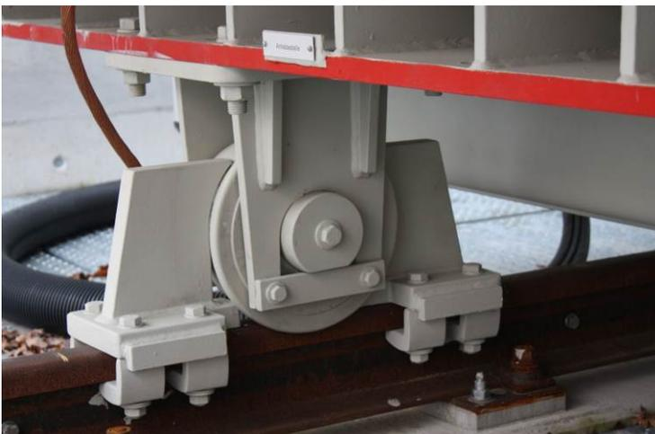
*Bild B.6* Trafo 110 kV / 40 MVA – Erdbebenzone Z1a – Verankerung mit zwei Hemmschuhen pro Rolle. Es ist auf das Ausknicken in Querrichtung und die Stabilität der Schiene zu achten; NUR in der Erdbebenzone Z1a anwendbar (mit Erlaubnis von ekz).
