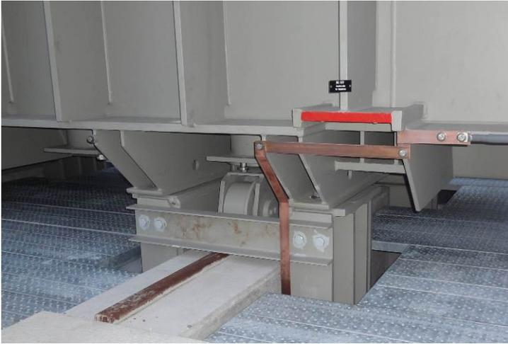
*Bild B.4* Trafo 110 kV / 125 MVA – Erdbebenzone Z2 – Verankerungen (4 lösbare) mit Fahrrollen (mit Erlaubnis von Axpo).
