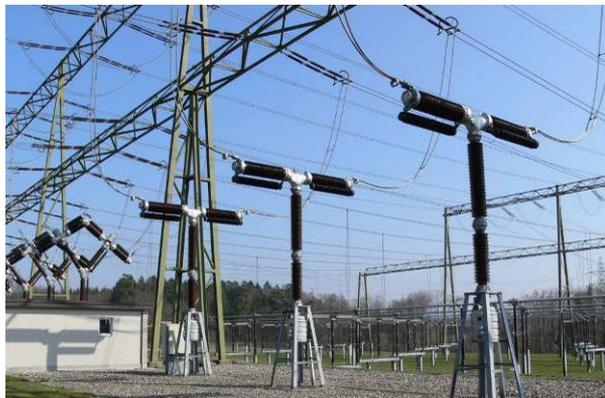
*Bild 2* 380 kV-Leistungsschalter, die über im Wesentlichen vertikale Leiterseile mit den Nachbar-Apparaten verbunden sind: Diese Konfiguration lässt grosse Erdbebenverschiebungen zu, ohne dass die Leiterseile straff werden und ohne dass sich zu grosse Kurzschlusskräfte ergeben.
