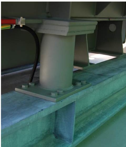
*Bild B.5* Trafo 50 kV / 25 MVA – Erdbebenzone Z1b – Verankerung auf ein verstärktes bestehendes Fundament (mit Erlaubnis von energie thun).
