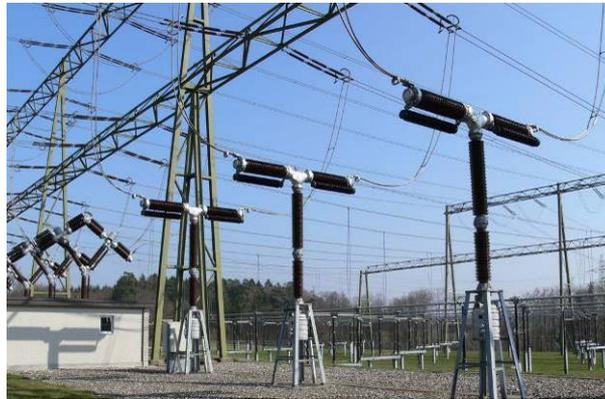
ill. 2 *Disjoncteurs de puissance de 380 kV reliés essentiellement par des câbles verticaux aux appareils voisins : cette configuration permet de grands déplacements sismiques sans provoquer la tension des câbles.*
