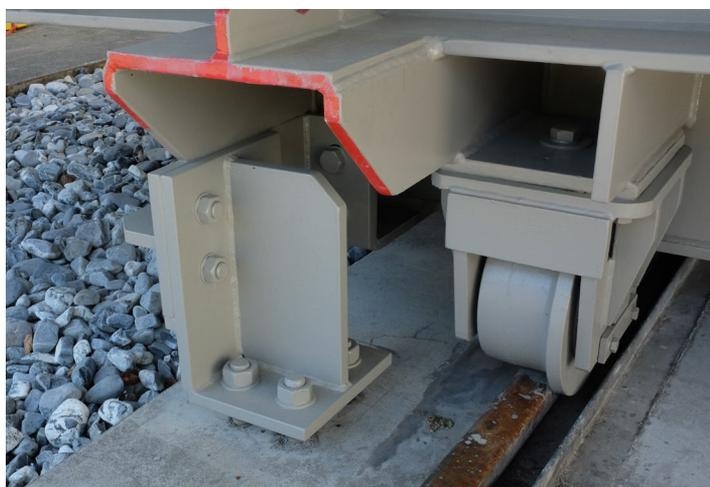
ill. B.3 Transformateur 110 kV / 60 MVA – Zone sismique Z2 – Ancrages (4 pces démontables) avec roues (avec autorisation d'Axpo).
