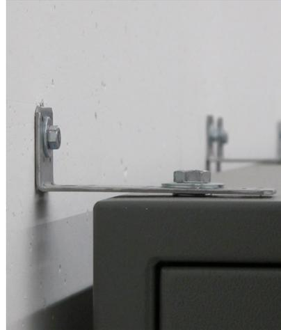
ill. E.4/E.5 *Sécurisation d'armoires de commande avec équerres contre le mur (Axpö)*
