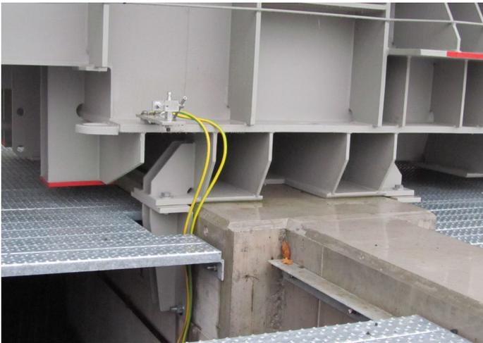
ill. B.1 Transformateur 220 kV / 70 MVA – Zone sismique Z3b – Ancrages (8 pces démontables) directement sur la fondation (avec autorisation d'Axpo).
