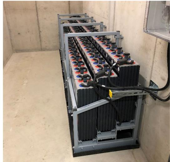
*ill. E.1/E.2 Sécurisation contre le basculement et la chute de batteries de secours : à gauche, SS Münchwilen (Axpo) : pieds du support entretoisés en diagonale et boulonnés au sol / à droite, SS Bassecourt (Swissgrid) : sécurisation du support par connexion avec le mur / les deux : barres horizontales empêchant le basculement des batteries.*
