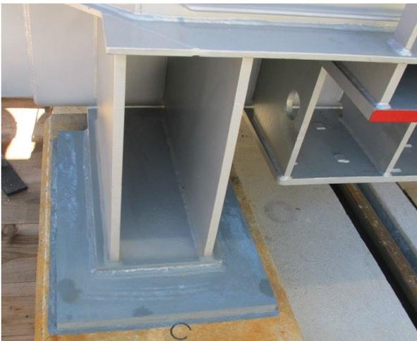
ill. B.2 Transformateur 236 kV / 60 MVA – Zone sismique Z3b – Cadre de renforcement soudé sur plaques d'ancrage coulées dans le béton (avec autorisation de ewz).
