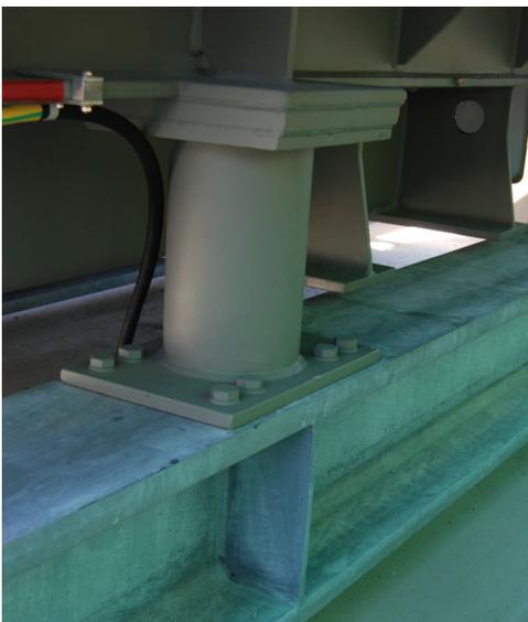
*ill. B.5 Transformateur 50 kV / 25 MVA – Zone sismique Z1b – Ancrage sur une fondation existante renforcée (avec autorisation de energie thun).*
