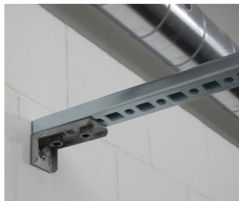
ill. E.7/E.8 *Sécurisation d'armoires de commande au centre d'une pièce jusqu'au mur (Axpö)*
