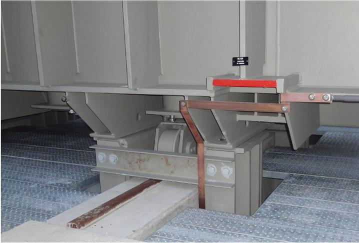
*ill. B.4 Transformateur 110 kV / 125 MVA – Zone sismique Z2 – Ancrages (4 pcs démontables) avec roues (avec autorisation d'Axpo).*
